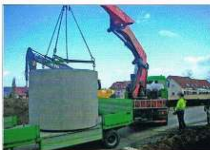
Der einbaufertige Pufferspeicher wurde direkt vom Lieferfahrzeug in die vorbereitete Erdgrube abgesetzt.
