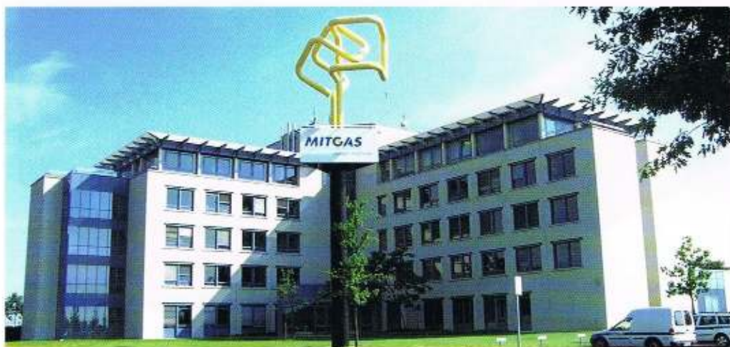
Die Hauptverwaltung der Mitgas GmbH in Kabelsketal.
