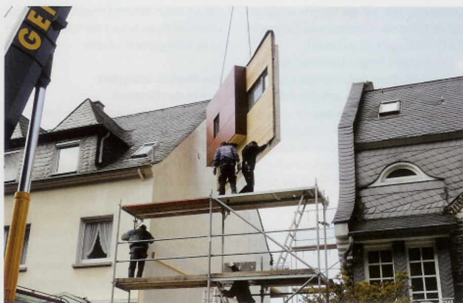
Die Firma Blum Holzbau fertigte die Holztafelbauelemente innerhalb von drei Wochen in der Firma vor. Die Montage dauerte nur einen Tag.
