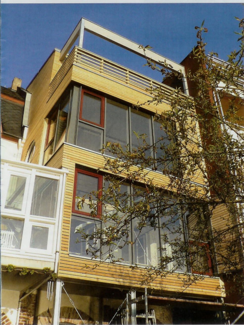
Auf der Rückseite des Gebäudes entstanden vier neue Geschosse. Das erste Geschoss ist auf Stahlpfosten aufgeständert, um das Gebäude vor zeitweise auftretendem Hochwasser zu schützen.
