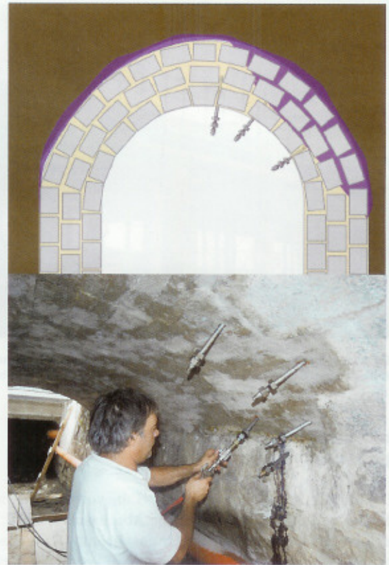
Das im Niederdruckverfahren injizierte DRYflex Injektionsharz erwies sich als besonders geeignet für die Sättigung der zahlreichen Hohlräume.
