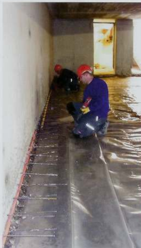
Injektionsprofile werden an den bestehenden Streifenfundamenten und den Stützenfundamenten befestigt
