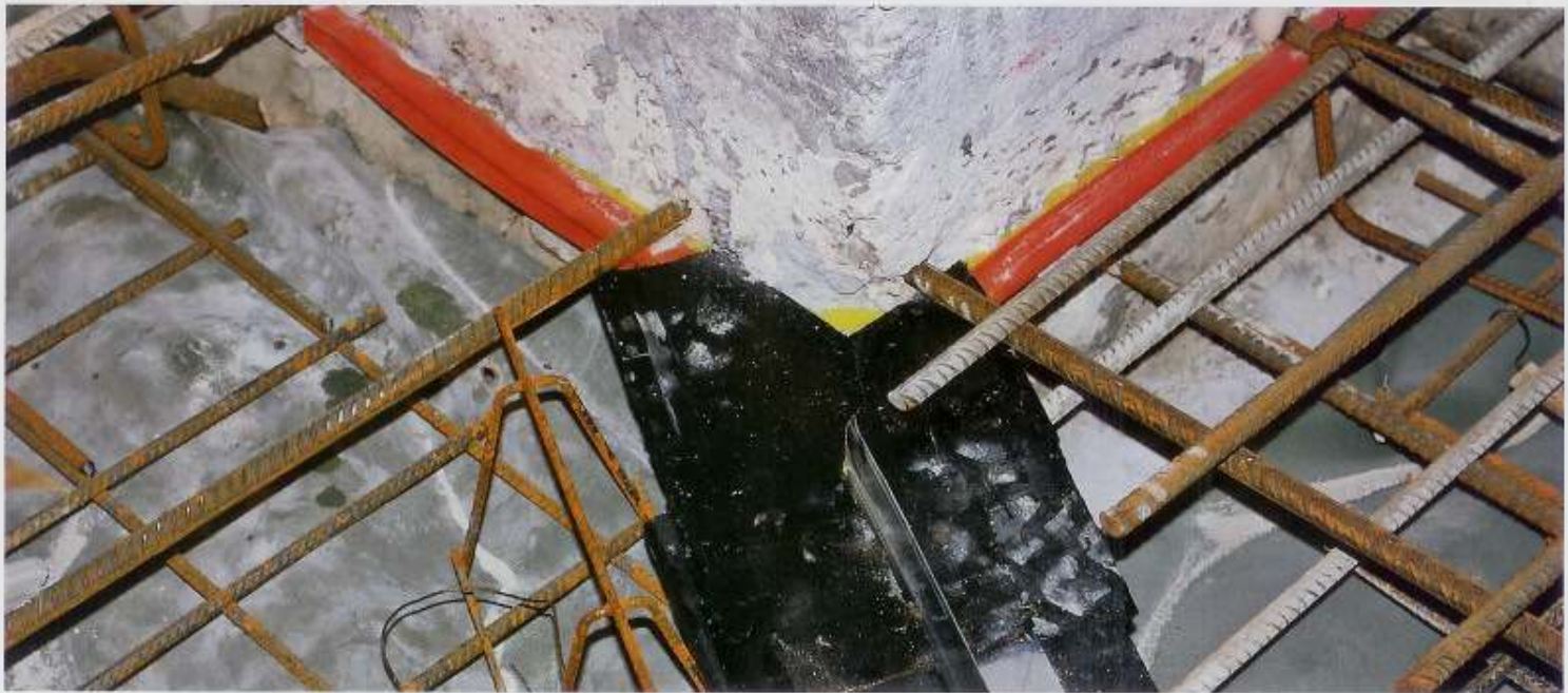
Anschluss Sollrisselement, Dichtelement an das Fundament
