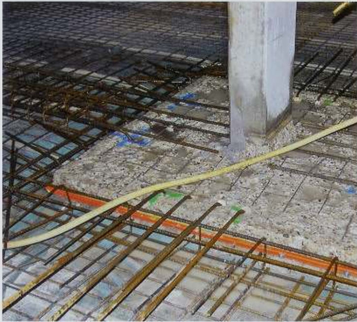
Einzelfundament mit Anschlussbewehrung und Verbügelung zum Einbinden in die Tragstreifen der Bodenplatte
