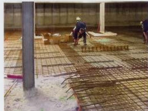
Die flexiblen Injektionskanäle passen sich jedem Untergrund an
