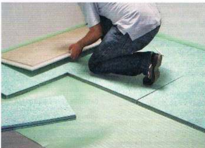
Die Vakuumpaneele weisen eine Wärmeleitfähigkeit von \lambda = 0,007 W/(m 2 K) auf und sind auch während der Verarbeitung behagbar und geschützt.
