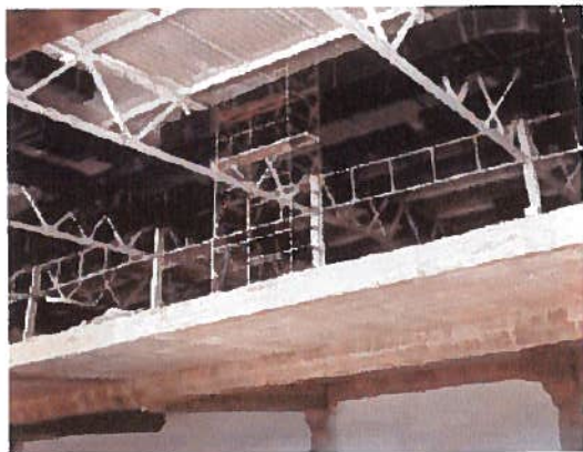
Betonver 1500 ha un ridotto peso specifico pur con un'elevata resistenza alla compressione e un modulo elastico pari a quello di un calcestruzzo tradizionale, per cui permette di dare dimensioni più ridotte alle strutture portanti in calcestruzzo
